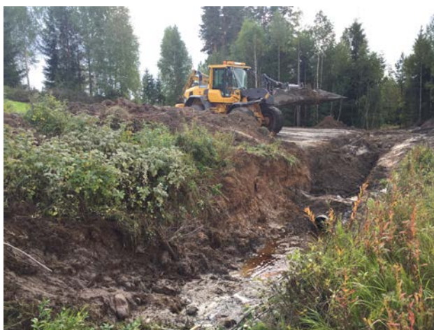
Trumbyte och sandfälla i utgången av kurva ett, var ett av årets större banarbeten.
